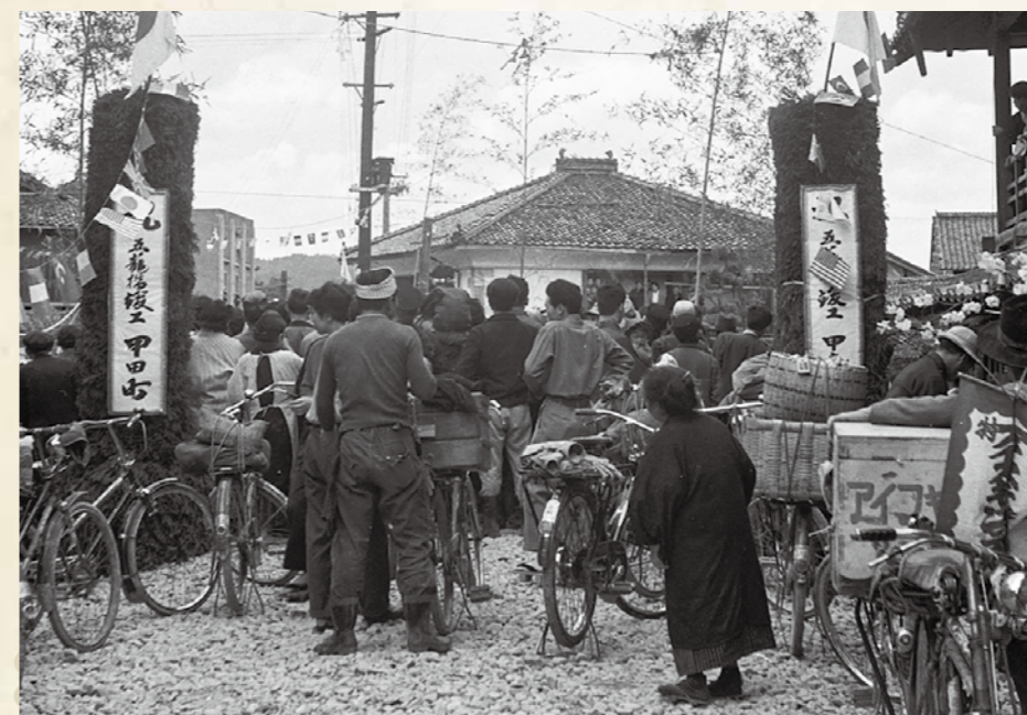
渡り初めを橋の手前(南)で見物する人々。2階からも見物していることが分かります(写真右上)。この辺りはかつて新町と呼ばれ、商店などが立ち並んでいました。写真手前にはアイスキャンディーを売る自転車。緑門には「五龍橋竣工甲田町」、4月1日に甲立町と小田村が合併して甲田町になったばかりでした。
