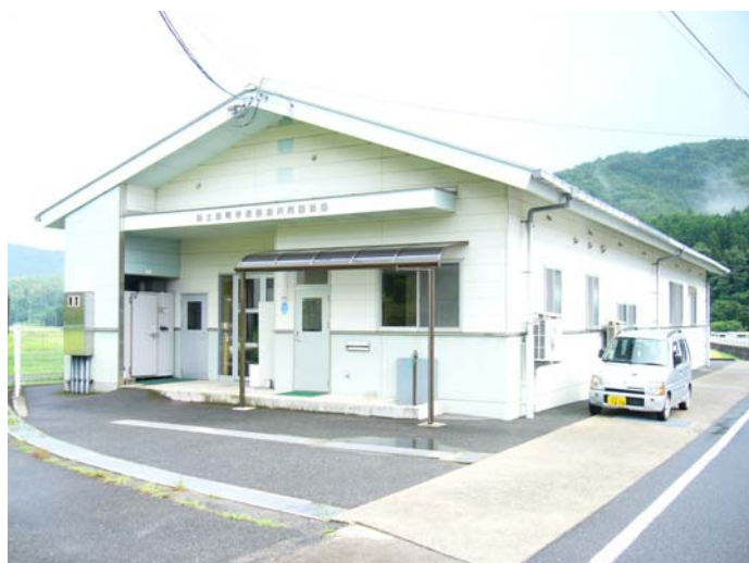
安芸高田市立美土里学校給食調理場
