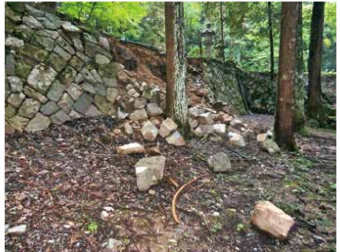
毛利元就墓所石垣崩落 (平成23年)
