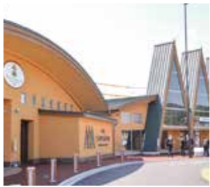
4月に一部オープンした「道の駅三矢の里あきたかた」
