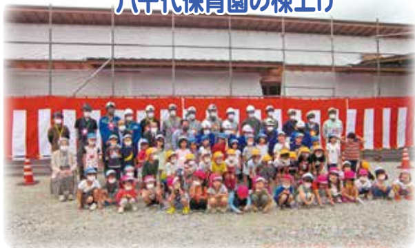
八千代保育園建設現場 (9月28日)
