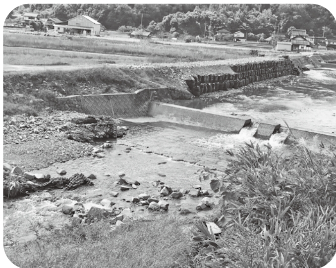
多治比川にある井堰の影響で水位上昇が起きた可能性がある
