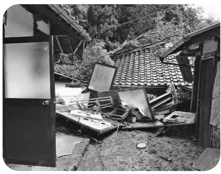
山腹崩壊により倒壊した家屋
