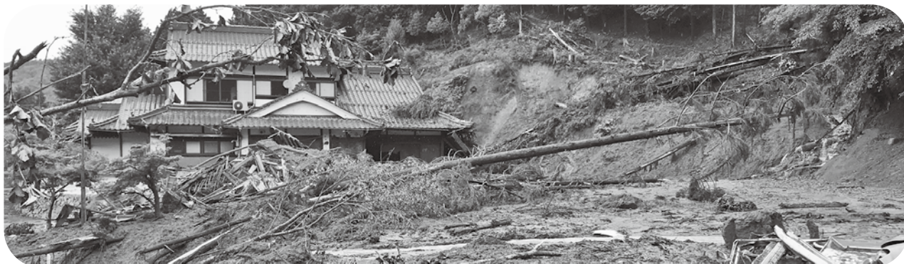
大規模土石流による被災現場
