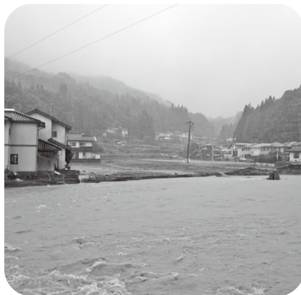
堤防が決壊した多治比川
