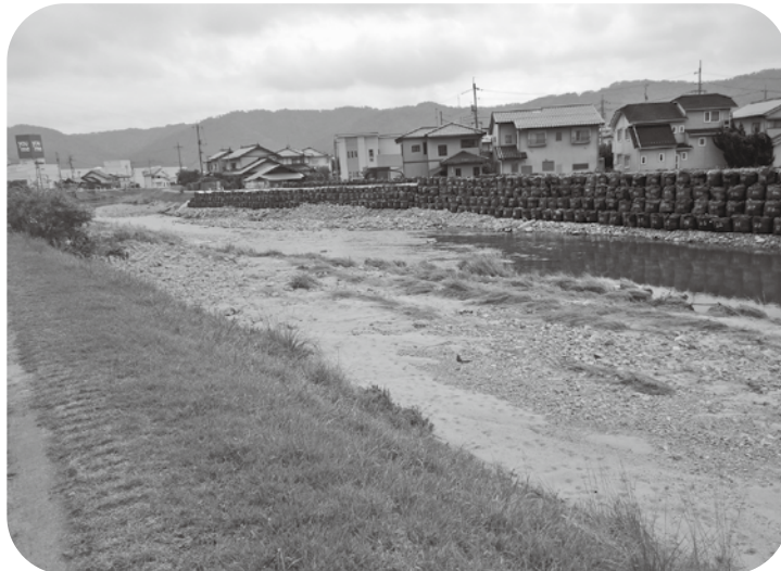
応急復旧された決壊した堤防 (8月27日時点)
