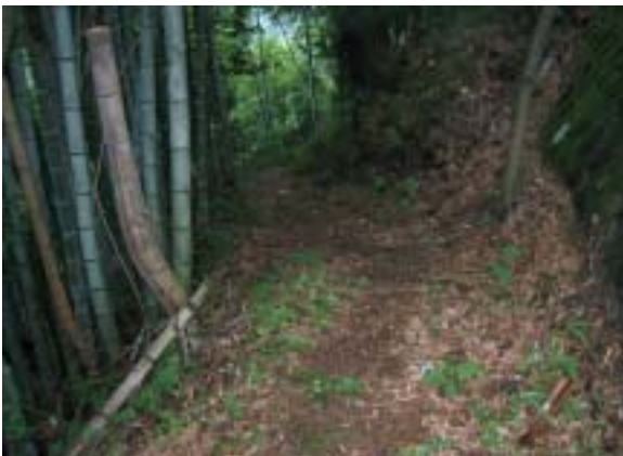
上根側入口付近の急坂の安全対策が必要です
