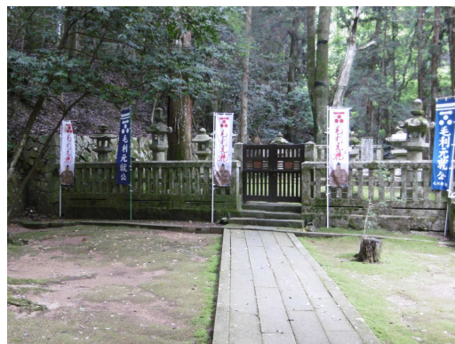
玉垣，門扉の修繕
