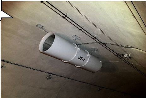
トンネル工区③
