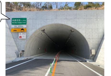
トンネル工区④
