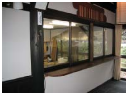
厨房との仕切りにアルミサッシを設置
