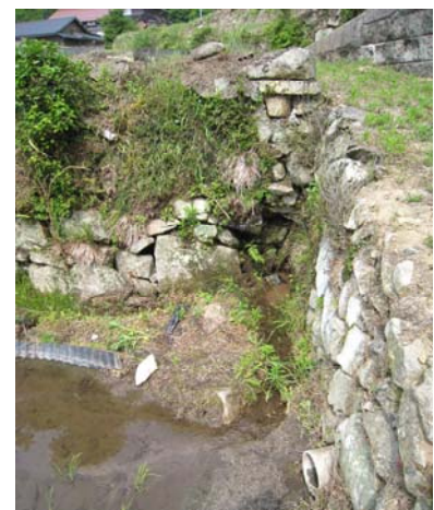
田の角の石積の間から水がしみ出て下の田を潤します
