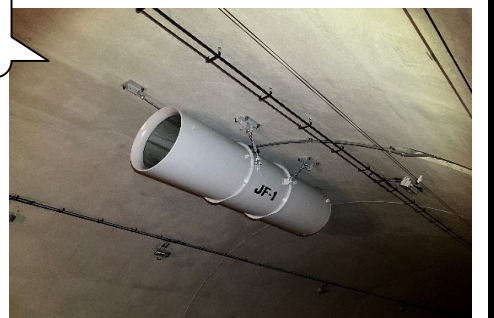
トンネル工区③
