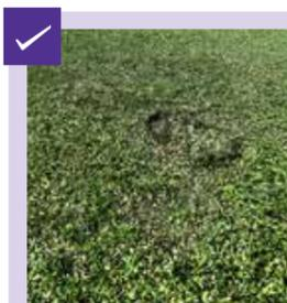
パイルが細くなり、ちぎれた状態。滑りやすくなりがにつながる恐れがあります。また充填物(ゴムチップなど)の偏り、厚みが薄いか所では衝撃吸収能力が低下し、転倒時に脳振とうの恐れがあります。
