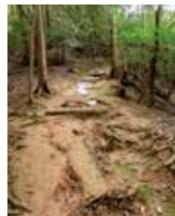
今回の土系舗装では自然由来の真砂土とセメントを混ぜた材料で施工しています。自然な色合いで景観になじみ、従来の地表面の登山道よりも強度が増し、耐久性が強化されました。
