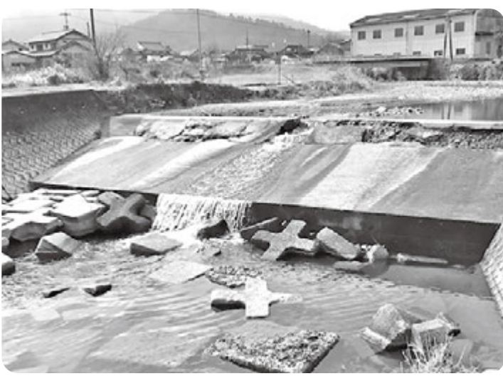
被災した井堰（甲田町）
