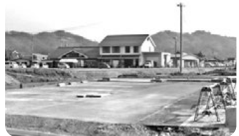
道の駅建設予定地
