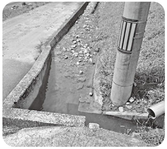
高齢者に厳しい水路の土砂
