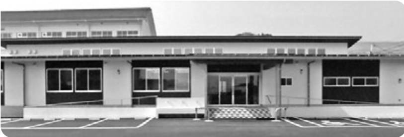
新設された甲立地域交流センター
