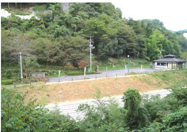
法面に草が生えていないので、今が植栽のチャンス
