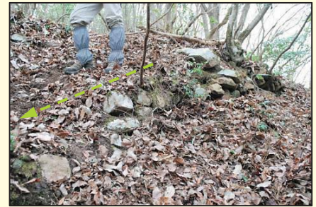
③の出入口の石積(東側より撮影)
