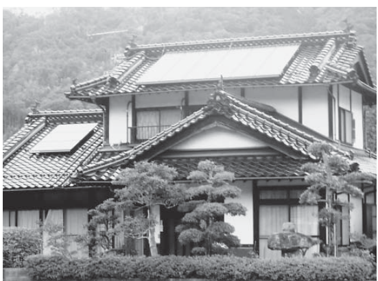
太陽光パネル発電システム
