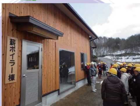
薪ボイラーの解説
