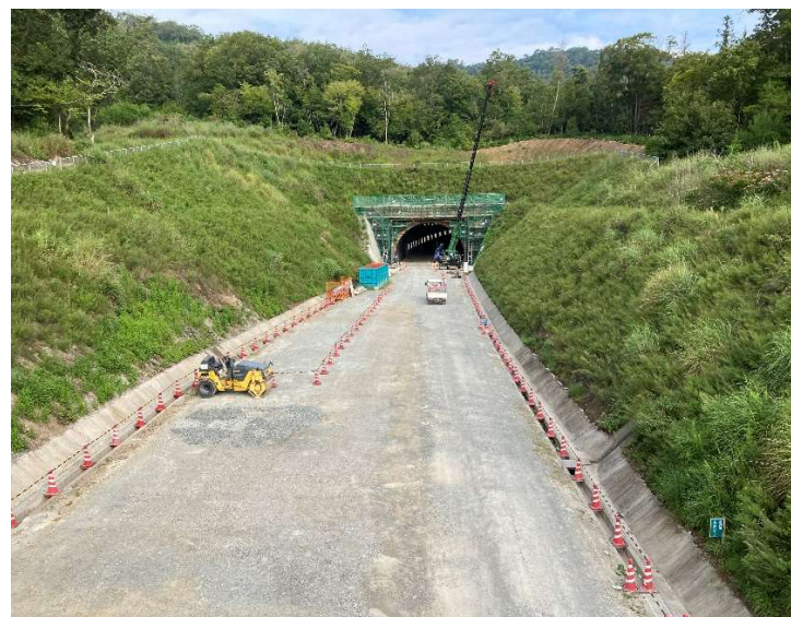
ヤード全景（坑口部）
