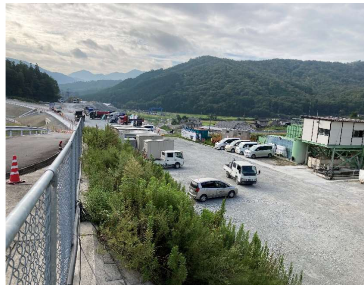
ヤード全景（仮設ヤード）
