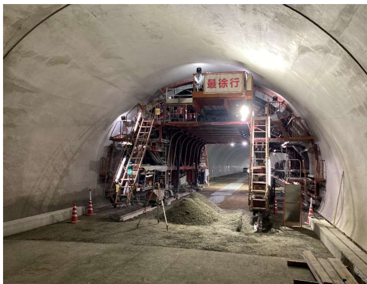
覆工コンクリート施工場所
