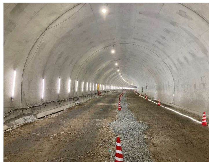
覆工コンクリート施工完了区間
