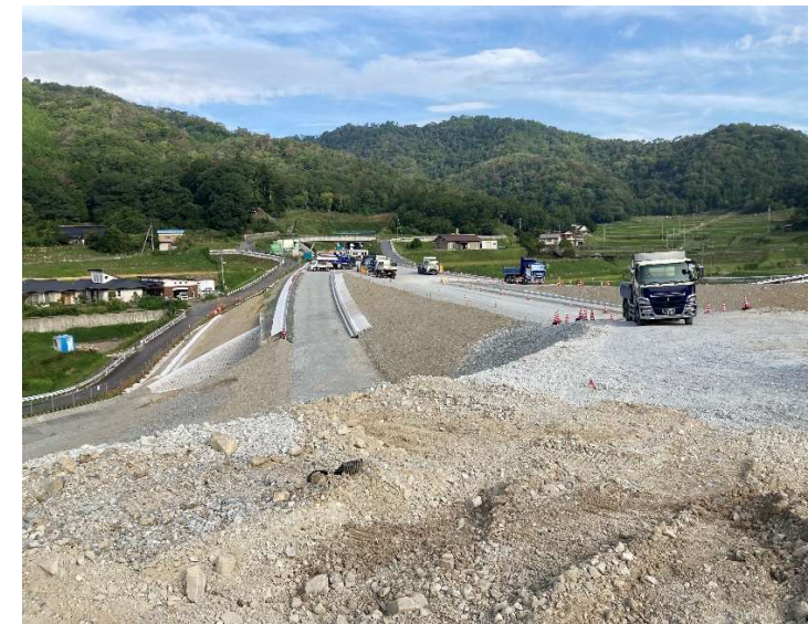
ヤード全景（工事起点より）
