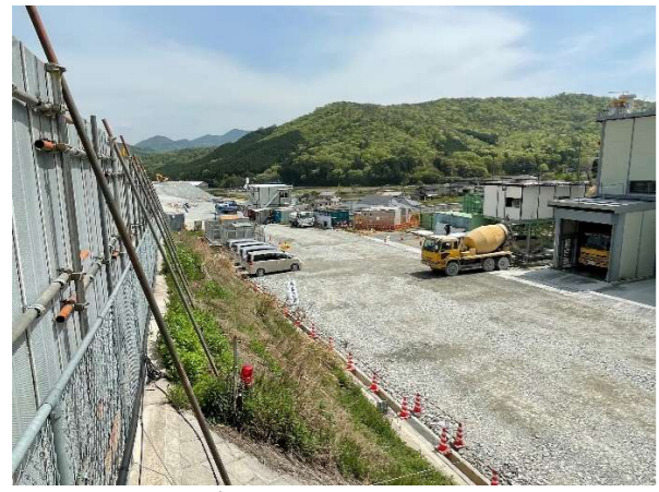
仮設ヤード状況
