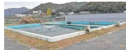
老朽化した上水道施設(緩速ろ過池)
