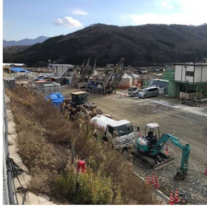
仮設ヤード状況
