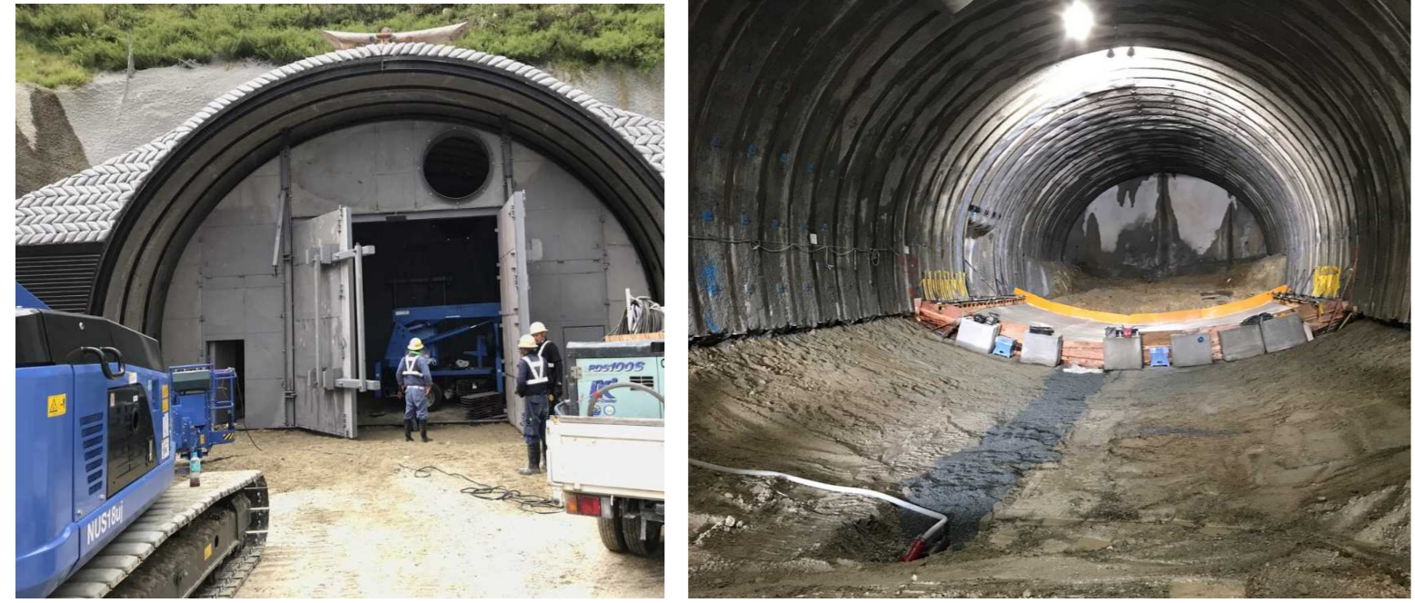
防音扉設置状況
