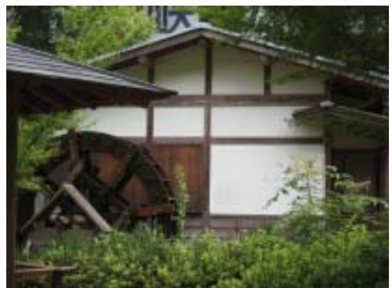
水車の改修を行います
