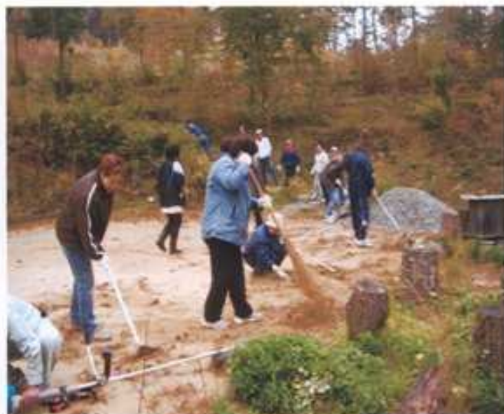
広場・遊歩道整備
