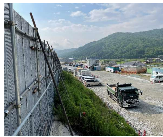
仮設ヤード状況
