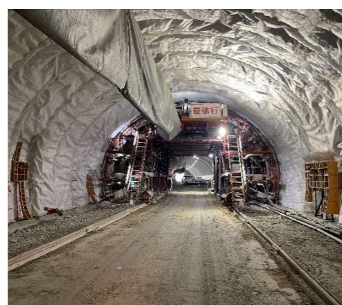
坑内状況（防水工）
