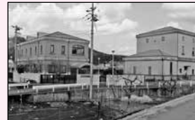
更新工事に着手している「甲田浄化センター」
