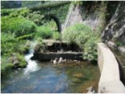
潜龍橋の下流にある井堰
