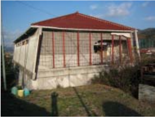
北側の壁は崩落しています
