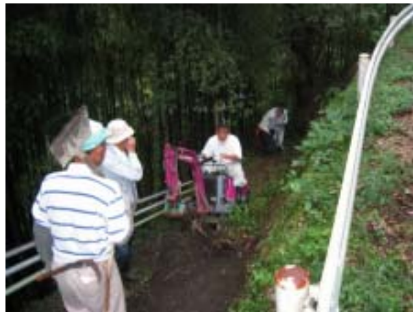
長年の歳月で多量の土砂が堆積していました
