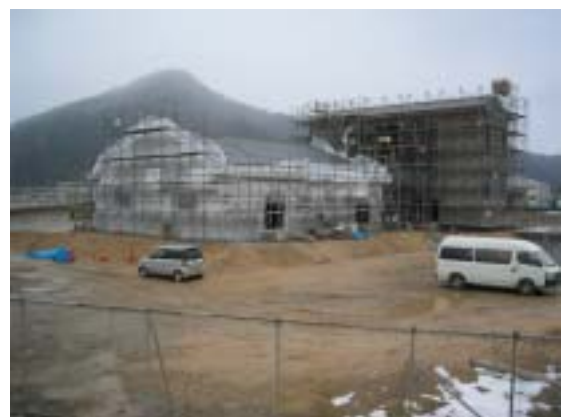
勝田・北原地区に建設中の浄化センター
