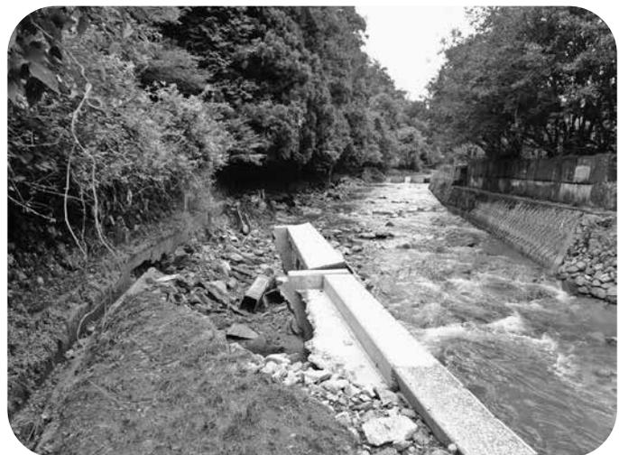
河川護岸の流失により、上流の井堰から取水できなくなった用水路(吉田町多治比隠地地区)
