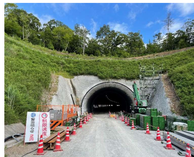
坑門工施工場所
