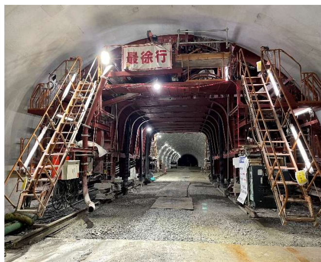
覆工コンクリート施工場所
