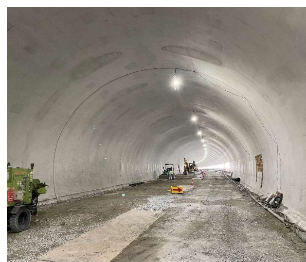
中央排水工施工状況
