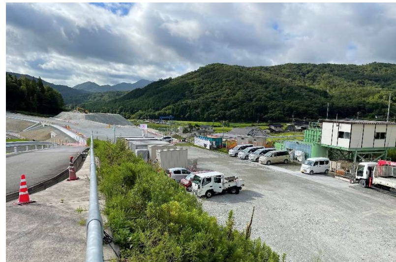
ヤード全景（仮設ヤード）
