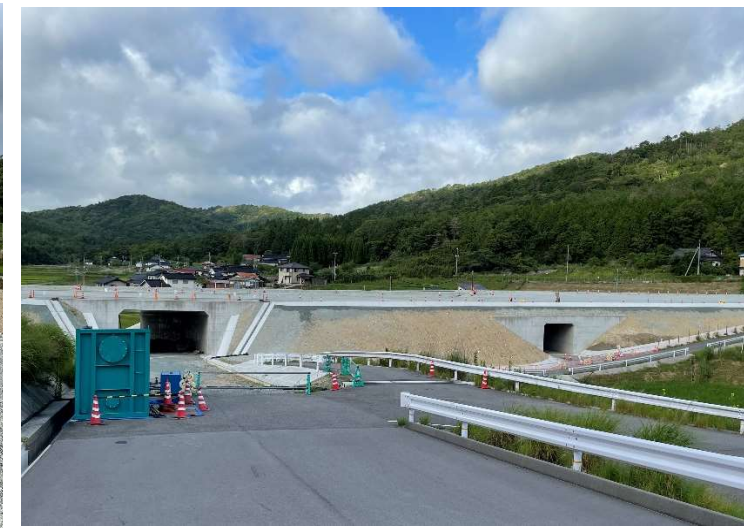
ヤード全景（右側より）
