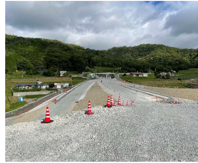
ヤード全景（工事起点より）
