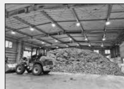
落ち葉（地域資源）が3m以上も積みあがっていた栃木県芳賀郡茂木町堆肥センター
